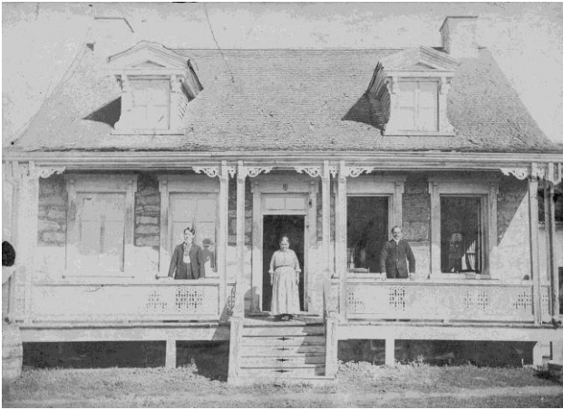
Maison Martin-Paquin. Photo vers 1900. Sur la galerie, Marcelline Boileau, épouse de Jean-Baptiste Paquin, et ses deux fils, Évariste et Vitalien.
