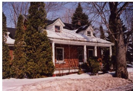
Maison de Noël Wilson puis d'Omer, 409, rue Monk, construite vers 1925. Photo R. Labastrou, 2007.
