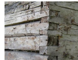
Maison d'Arthur Wilson, 1244, montée Wilson. Photo R. Labastrou 2007. Rénovée en 2009, l'enlèvement du revêtement de briques a montré la structure de pièce sur pièce en gros madriers de pin équarris à la hache avec assemblage à mi-bois et à coulisse avec chevilles de bois.
