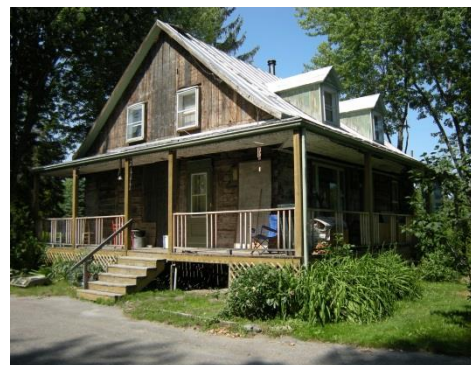
Maison Jean-Baptiste Brunet, structure de bois ancienne découverte en 2008, après l'enlèvement du parement de briques et avant son recouvrement actuel.
