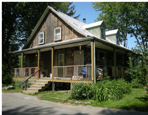
Maison d'Arthur Wilson, 1244, montée Wilson. Rénovée en 2009, l'enlèvement du revêtement de briques a montré la structure de pièce sur pièce en gros madriers de pin équarris à la hache avec assemblage à mi-bois et à coulisse avec chevilles de bois. Photo R. Labastrou 2009.
