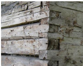
Maison d'Arthur Wilson, 1244, montée Wilson. Rénovée en 2009, l'enlèvement du revêtement de briques a montré la structure de pièce sur pièce en gros madriers de pin équarris à la hache avec assemblage à mi-bois et à coulisse avec chevilles de bois. Photo R. Labastrou 2009.
