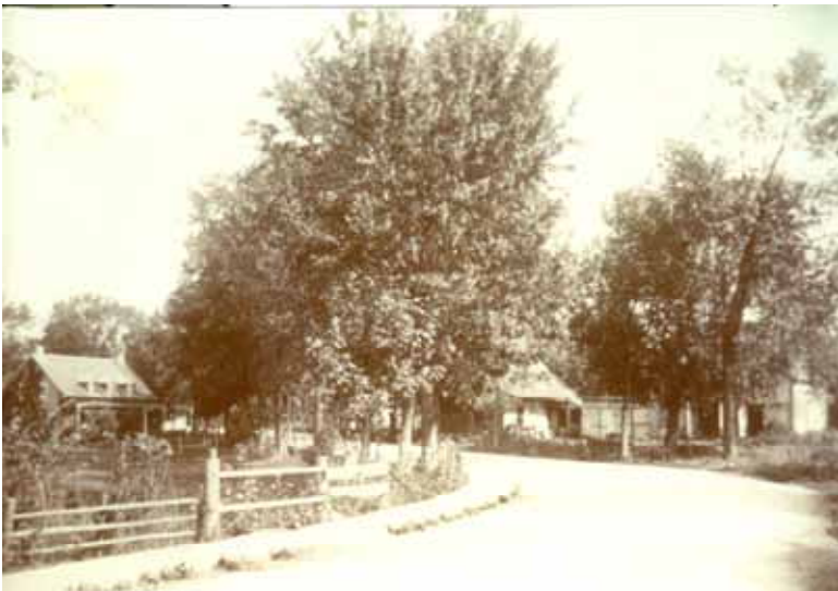
Le boulevard Gouin pas très loin de ton école, vers 1920.
