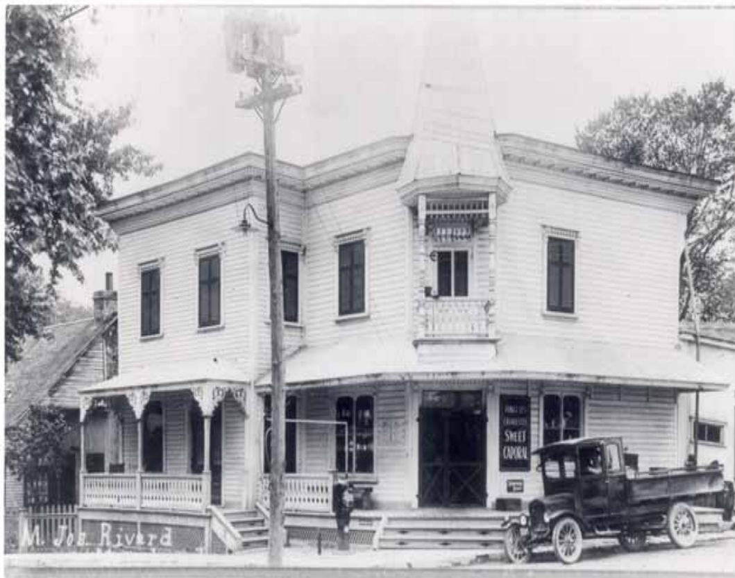
15,796 boul. Gouin. ( construction, date inconnue, édifice incendié )
